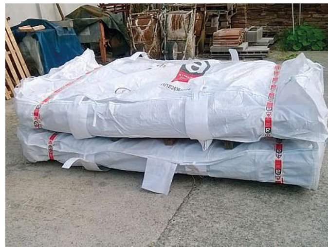
Lastre di amianto imballate in vista dell'operazione di smaltimento
