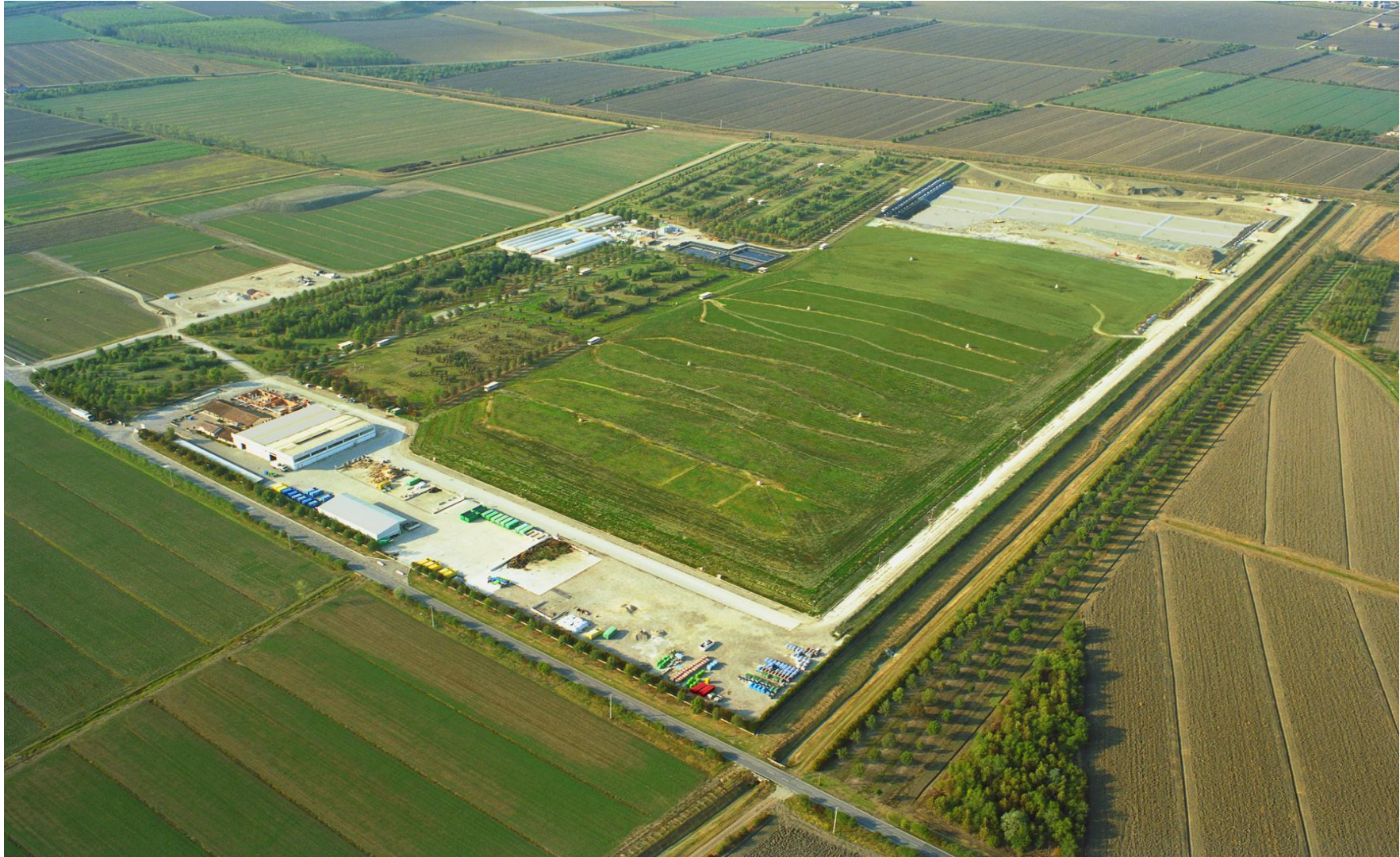
Fig. 1.2 - Veduta aerea dell'impianto (Fonte: S.A.Ba.R. Spa, Relazione annuale 2011)
