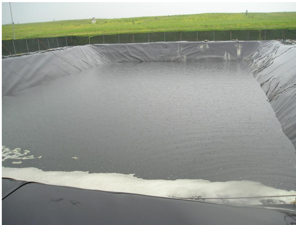
Figura 9- Vasca di accumulo del percolato
